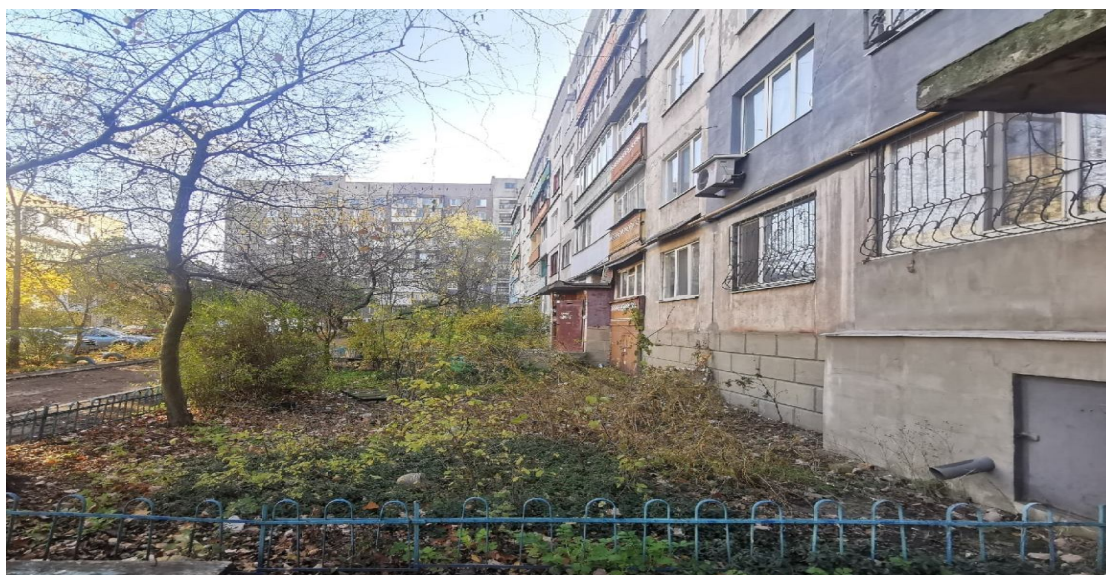
Рисунок 7 — Существующий палисадник по адресу ул. Гмыри, д. 21а
