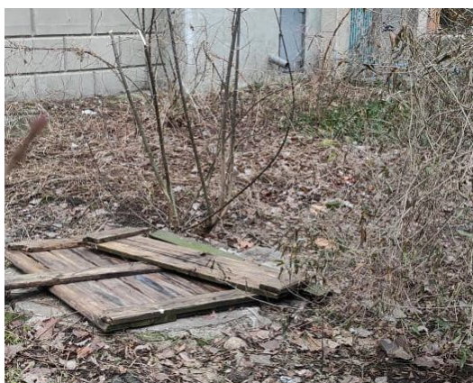
Рисунок 2 — Канализационный колодец в палисаднике по адресу ул. Гмыри, д. 21а
