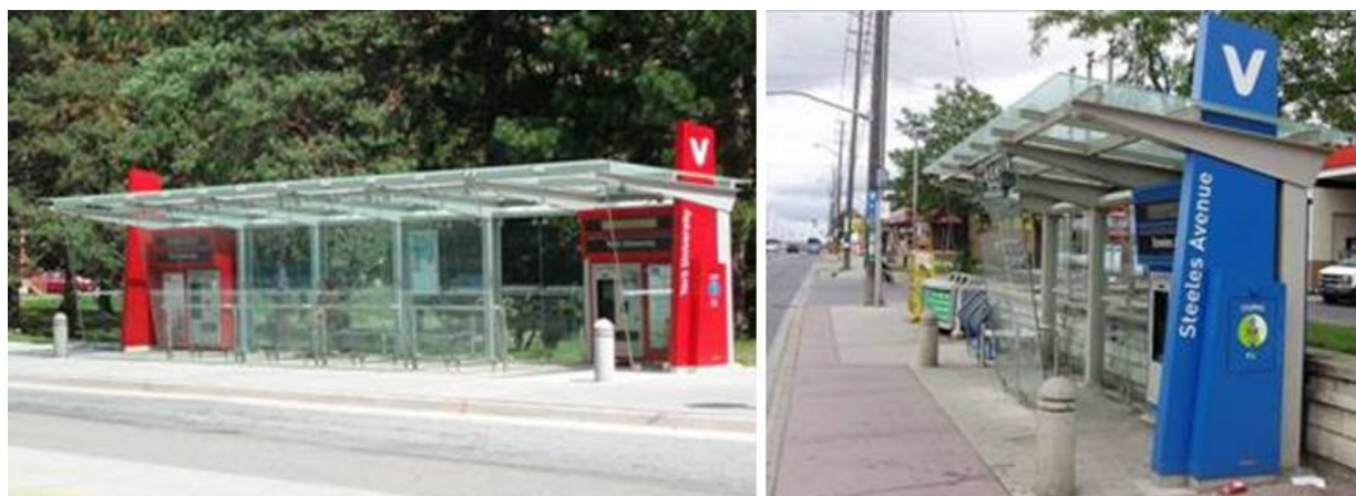
Рисунок 8 – Остановки, оборудуемые защитными армированными полуметровыми столбиками, увеличенной высотой тротуара и защитой от брызг из-под колёс проходящего мимо транспорта – оснащённый остановочный павильон с остеклёнными перегородками
