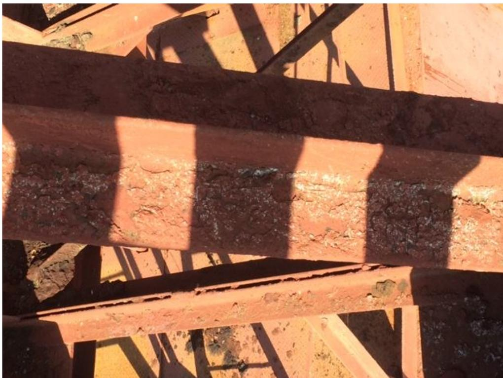
Рисунок 1 Отслаивание лакокрасочного покрытия
