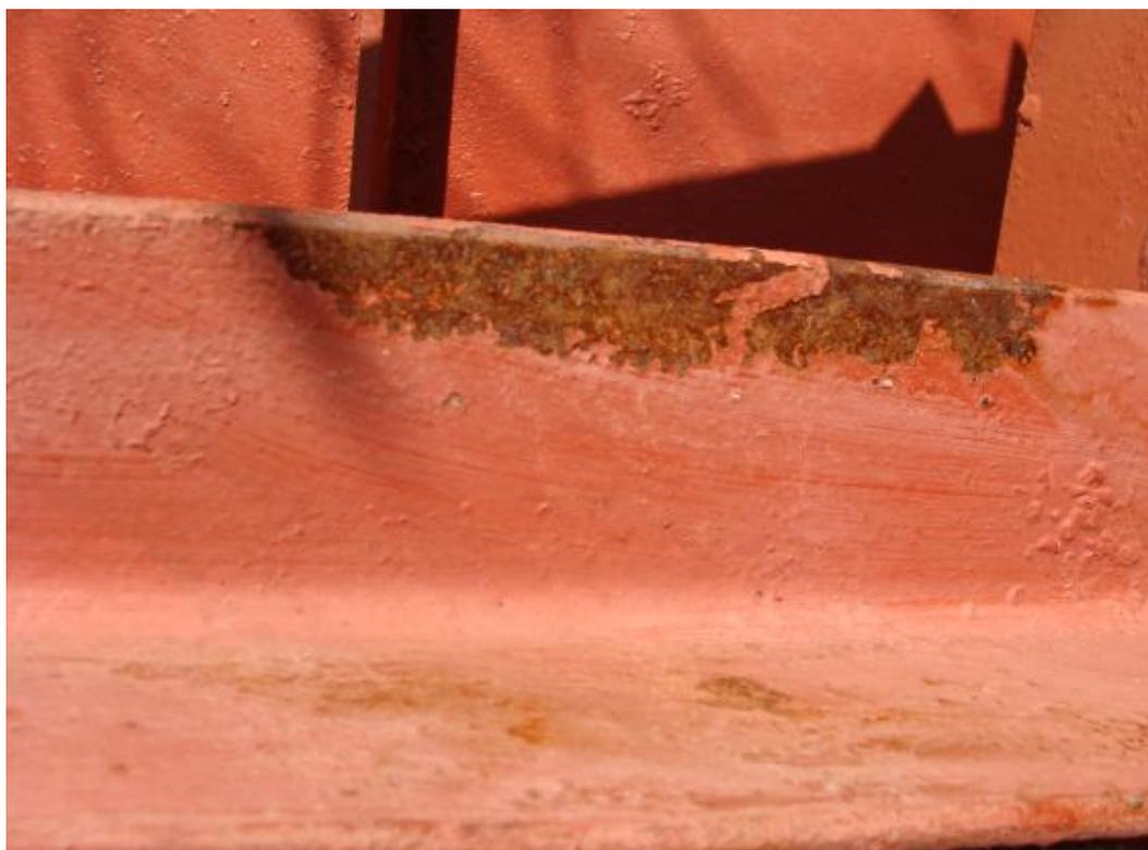
Рисунок 3 Проявление ржавчины на поверхности
